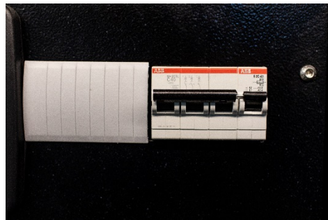
Электрическая часть ДГУ производства АВВ
