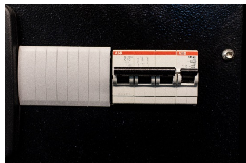
Электрическая часть ДГУ производства АBB
