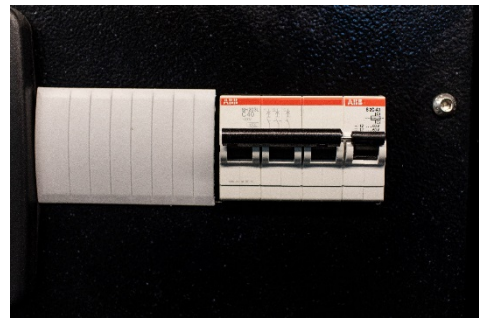
Электрическая часть ДГУ производства АВВ
