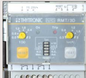
INTERRUTTORE DIFFERENZIALE EARTH FAULT BREAKER
