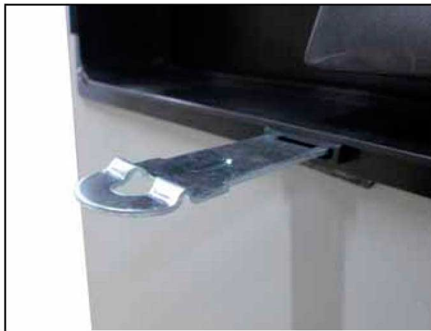
Рис. 3-6. Установка засова на смотровое окно
